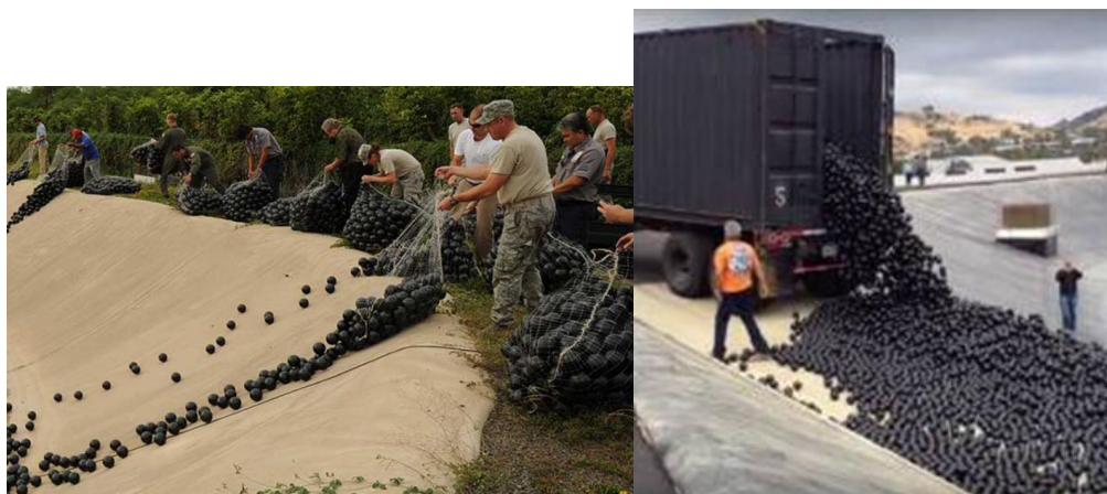
Photo 1 : mise en place manuelle ou par camion (crédits photo : à gauche : awtti.com – à droite : Shandong Shenghai health-care product Co.,Ltd)
